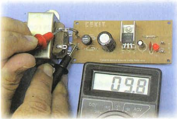
Figura 12.12. Midiendo el voltaje de salida de CA en el secundario del transformador
